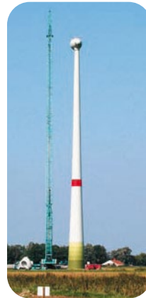
Turm vor Montage Tower before monting
