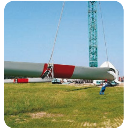
Montage eines Rotorflügels (L = 35 m) Assembly of a rotor blade (L = 35 m)
