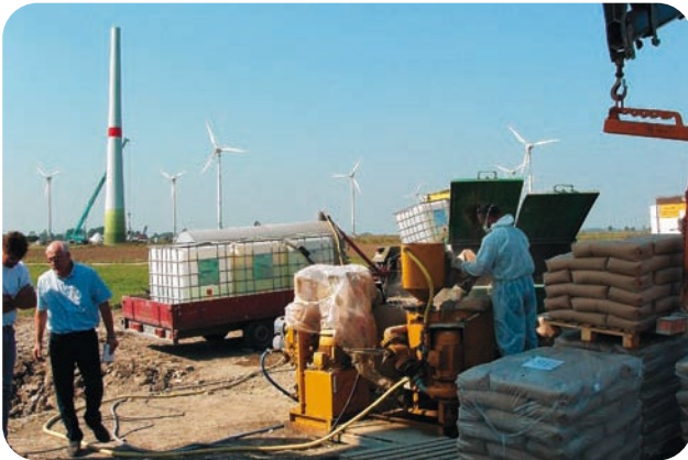
Häny Anlage beim Verpressen Häny in operation
