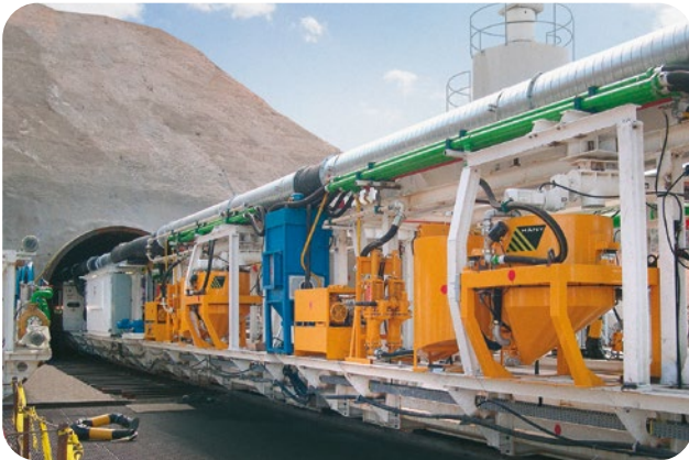
Aufbau der TBM vor Portal Assembly of TMB at tunnel portal
